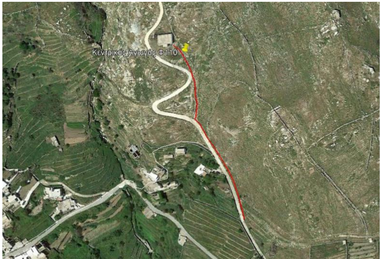
(Φωτ 1.) Αντικατάσταση κεντρικού δικτύου ύδρευσης στην Τοπ. Κοιν. Πιτροφού
