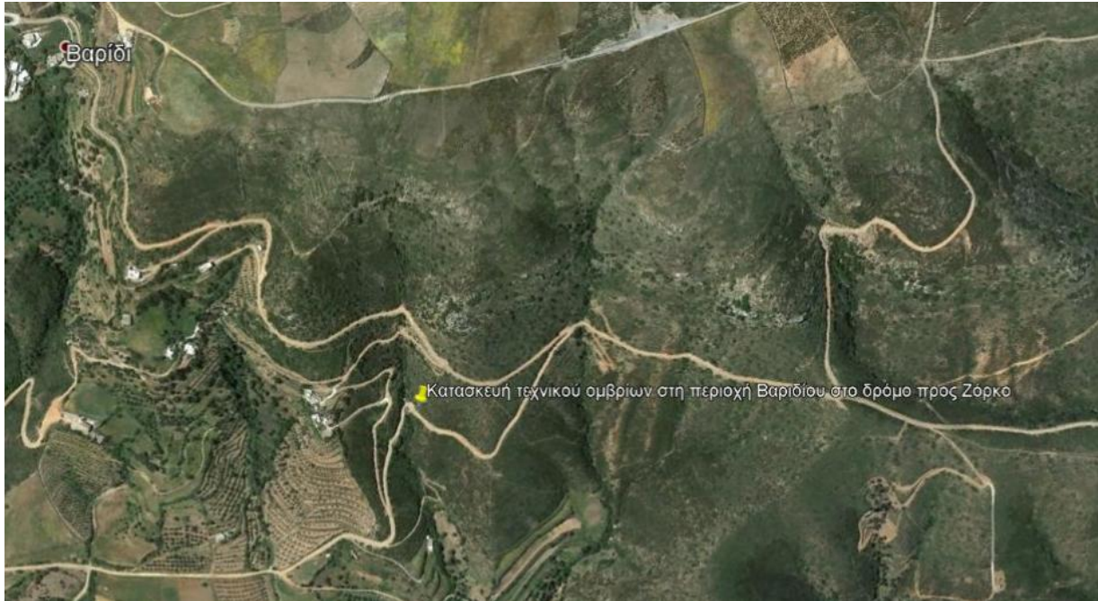
(Φωτ. 1) Κατασκευή τεχνικού ομβρίων στην περιοχή Βαριδίου στο δρόμο προς Ζόργκο
