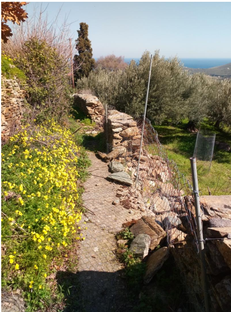
Σημείο 8. Αποκατάσταση τοίχου αντιστήριξης στον οικισμό Λάμυρα
