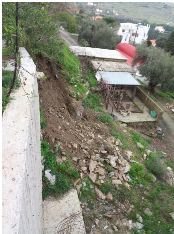
Σημείο 5. Επισκευή τοίχου αντιστήριξης στον οικισμό Λειβάδια, πλησίον ιδιοκτησίας Μανάλη Γ.
