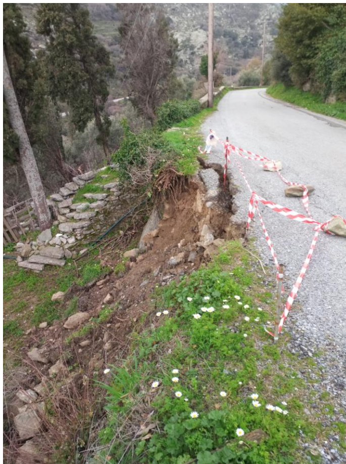
Σημείο. 10. Αποκατάσταση τοίχου αντιστήριξης στα Αποίκια, πλησίον ιδιοκτησίας Ρούσου Νικόλαου
