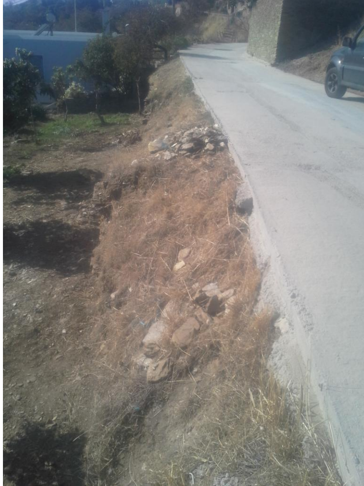
Σημείο 6. Επισκευή τοίχου αντιστήριξης στη θέση «Βεντούρι»
