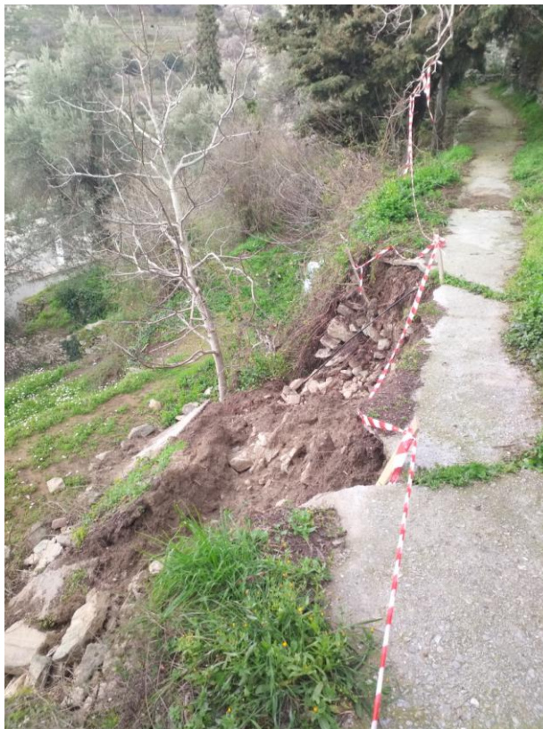
Σημείο 9. Αποκατάσταση τοίχου αντιστήριξης στον δρόμο προς Πυθάρα, Αποίκια
