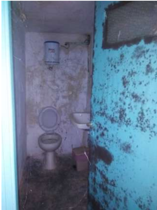
Φωτ.4 Υφιστάμενη κατάσταση wc
