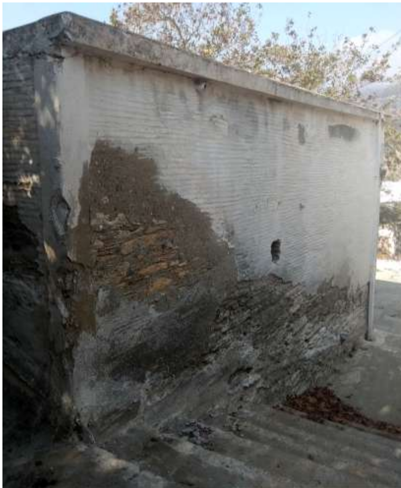
Φωτ.2 Πλάγια όψη Κοινοτικού γραφείου
