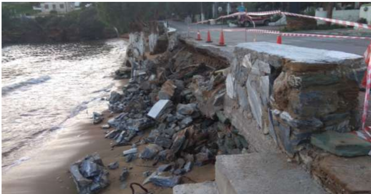
Αποκατάσταση τμήματος τοιχίου αντιστήριξης της παραλιακής οδού Μπατσίου
