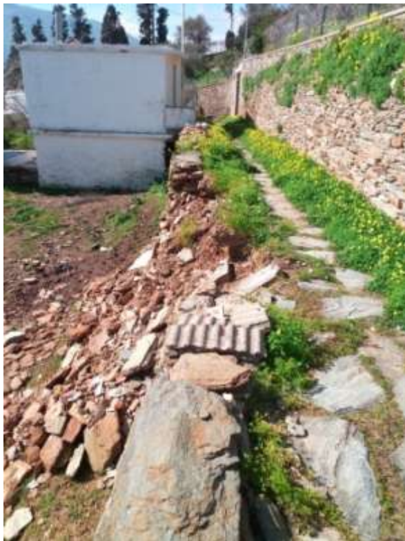
Σημείο 8. Επισκευή τοιχίου αντιστήριξης από λιθοδομή, πλησίον της οικίας Γιαννίση - Τσιτσιλώνη, στην Τοπ. Κοιν. Λαμύρων
