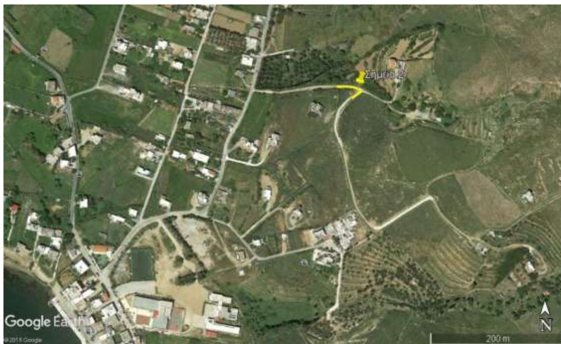
Σημείο 2 : Αποκατάσταση τμήματος οδού προς Δεξαμενή Γαυρίου, στην Τοπ. Κοιν. Γαυρίου.
