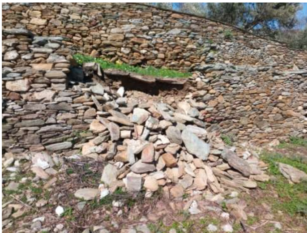
Σημείο 10. Επισκευή τοιχίου αντιστήριξης από λιθοδομή, πλησίον κοιμητηρίου Μεσαθουρίου, στην Τοπ. Κοιν. Λαμύρων
