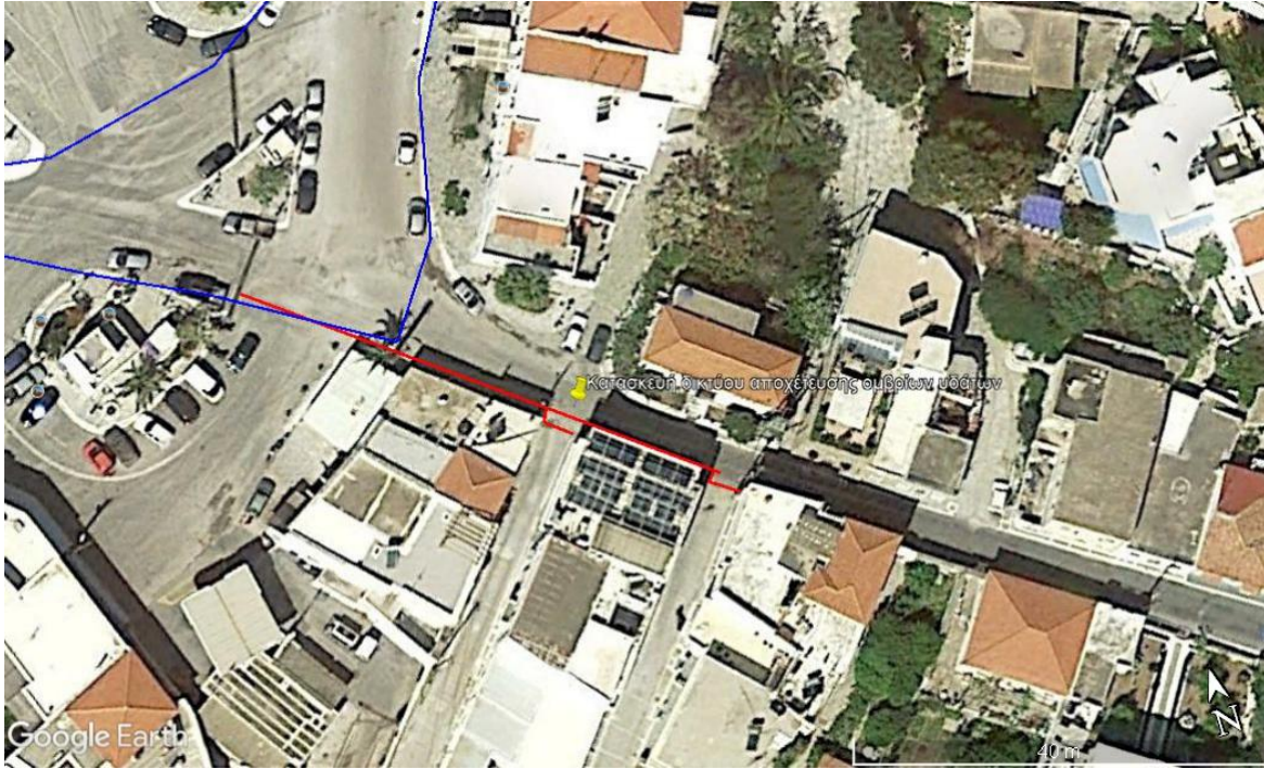
1.4. Κατασκευή δικτύου αποχέτευσης ομβρίων υδάτων στην είσοδο του λιμένα Γαυρίου
