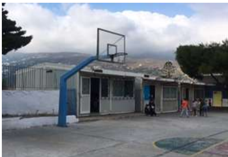
ΑΙΘΟΥΣΕΣ ΠΟΥ ΚΑΤΕΔΑΦΙΖΟΝΤΑΙ
