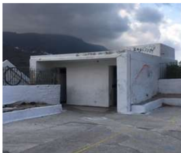
W.C. ΠΟΥ ΚΑΤΕΔΑΦΙΖΟΝΤΑΙ
