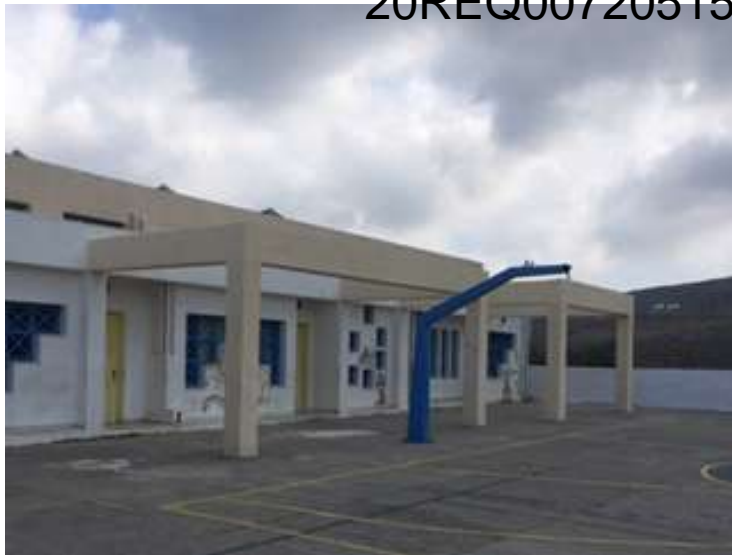
ΑΙΘΟΥΣΕΣ ΠΟΥ ΚΑΤΕΔΑΦΙΖΟΝΤΑΙ
