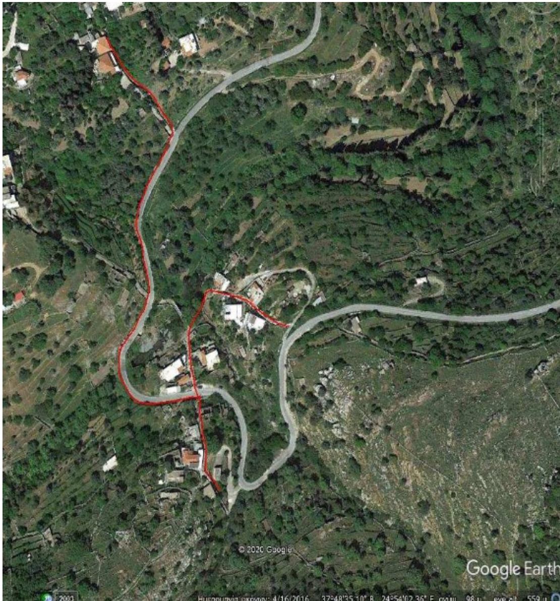
Φωτ. 1. Αντικατάσταση κεντρικού αγωγού ύδρευσης στην Τοπ. Κοιν. Μεσσαριάς στο χωριό Αλαδινό.
